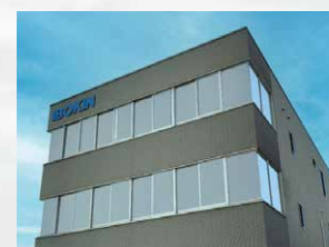
本部ビル (管理本部・解体工事部) 〒671-1631 兵庫県たつの市揖保川町山津屋140-14 Tel.0791-72-5088 Fax.0791-72-7400
